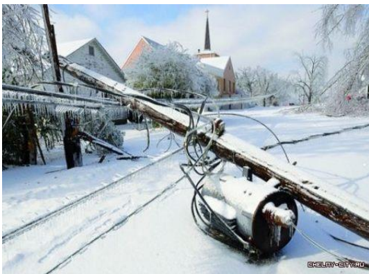
Рисунок 1,2 - Обледенение линий электропередач
