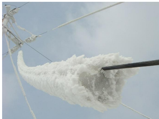
Рисунок 1,2 - Обледенение линий электропередач
